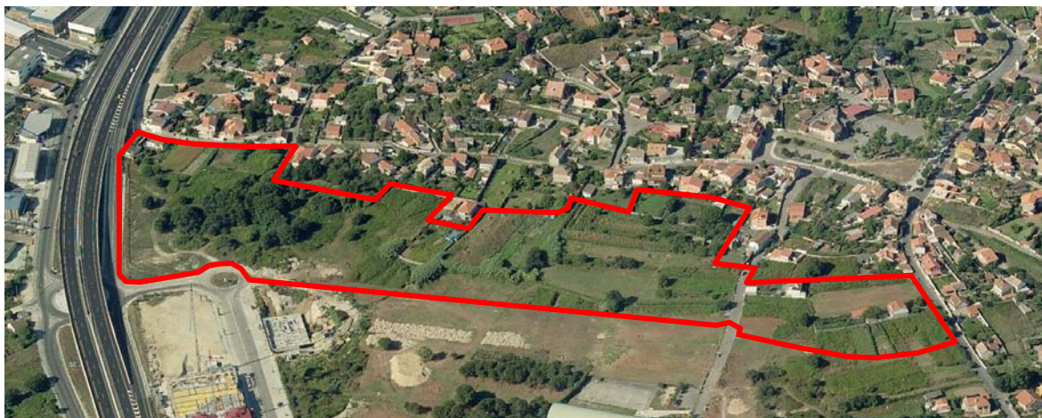
Fig. 28. Etapa III Fase B, estado actual.
